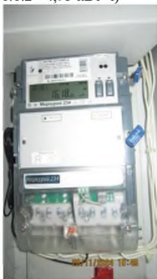
Прибор учета э/энергии в пом.6 (1.8.1- 16,18 кВт-ч, 1.8.2 - 4,93 кВт-ч)
