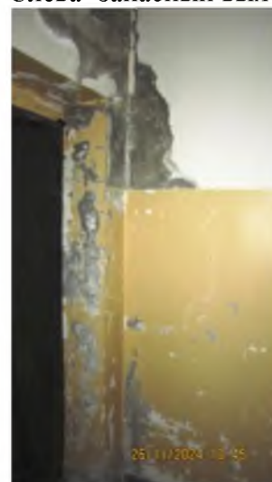
Пом.6. Тамбур. Слева- запасный выход.
