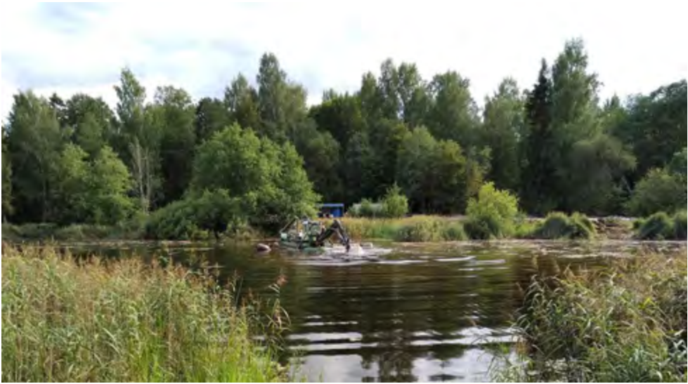
Рисунок 3.2. Расчистка озера Филькино Гатчинского района
